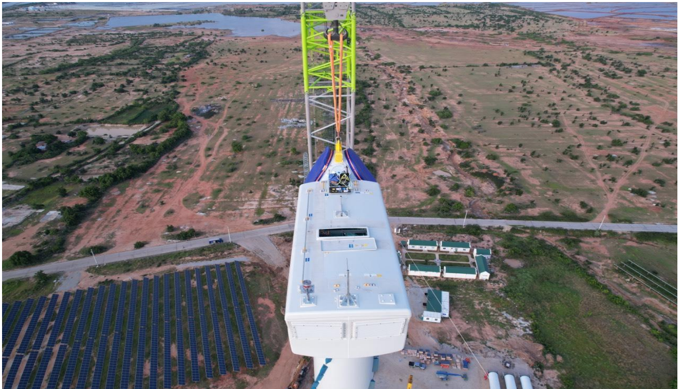
Top section and Nacelle installing Lắp đặt đốt trên cùng và tuabin phát điện
