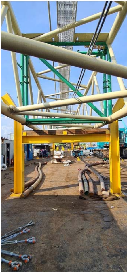
Lashing for seatowing/Chằng buộc đi biển
