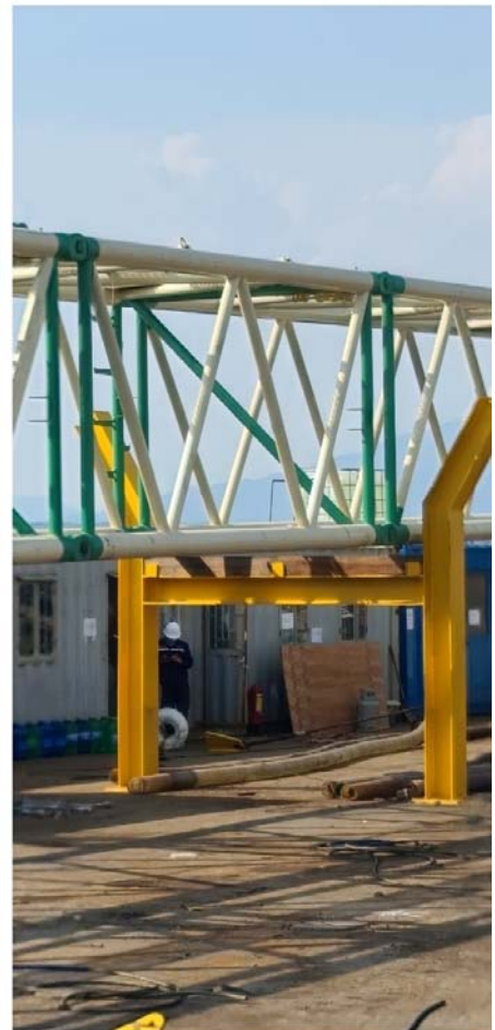
Lashing for seatowing/Chằng buộc đi biển
