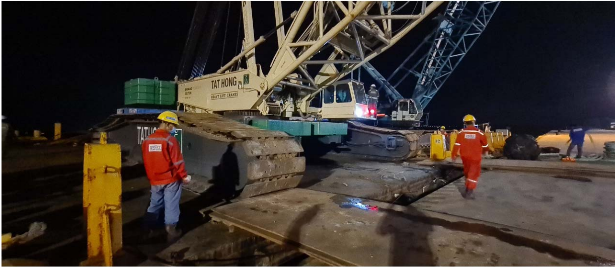
Load-out (roll on) to barge/Chuyển cầu 250T, 600T xuống xà lan
